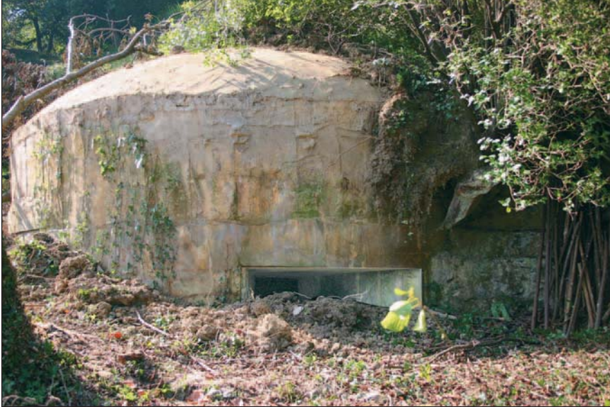
Fig. 22: Gaintxurizketa: Vista exterior de un nido de la obra n. 3.
